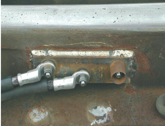
Plaque prête à souder équipée de 3 inserts courts 3 short rail bonds on plate ready to be welded
